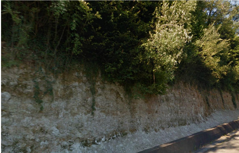
Figure 2 : Les calcaires massifs de la Formation de Neuvic, dans la tranchée de la RD 6089
