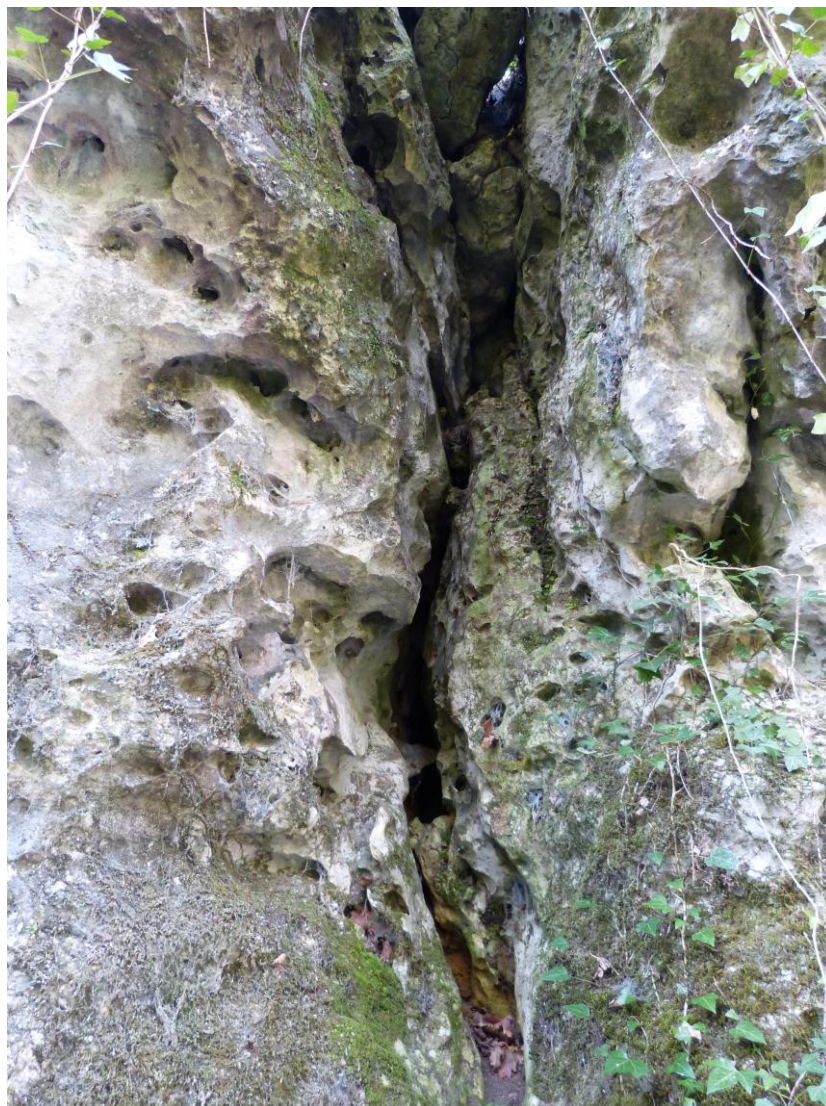
Figure 2 : Fracture dans l'axe est-sud-est / ouest-nord-ouest de l'anticlinal, élargie par la karstification (Platel JP., 2014)
