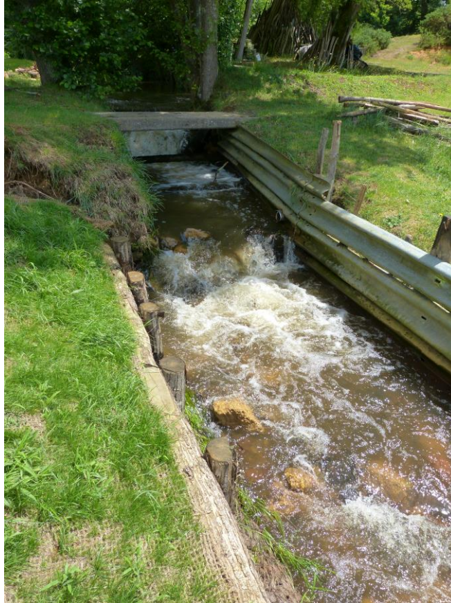
Figure 2 : Fort débit du ruisseau de Libé, drainant les alluvions de la terrasse du Pléistocène (en hautes eaux au mois de mai) (© Platel JP., 2015).
