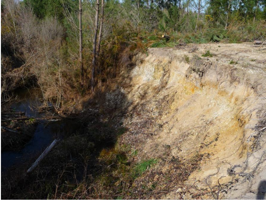
Figure 2 : Coupe des alluvions, au pont de la route D105, entaillées par le ruisseau de la Cabaleyre (© Platel JP., 2015).
