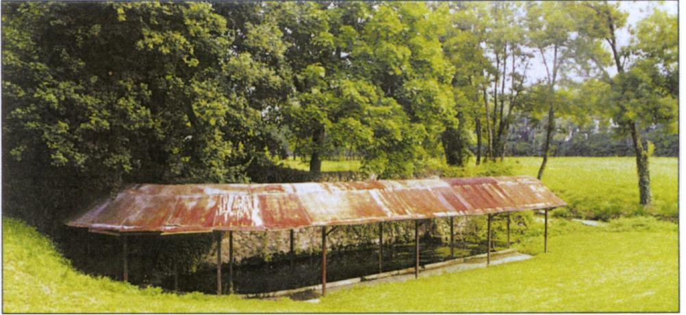
Son toit est recouvert de tôles ondulées sur une charpente métallique. Il est propre mais quelque peu abîmé. Les lavandières y lavaient à genoux.
