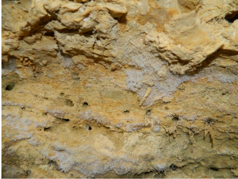
Figure 3 : Efflorescence de syngénite à la base des bancs d'huîtres de Sainte-Croix-du-Mont (© BRGM)
