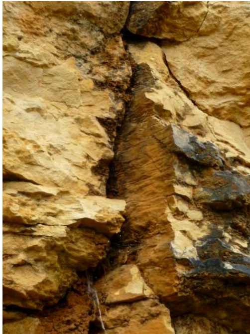
Figure 4 : Diaclase élargie par la circulation de l'eau dans les calcaires gréseux du Turonien à Couvert
