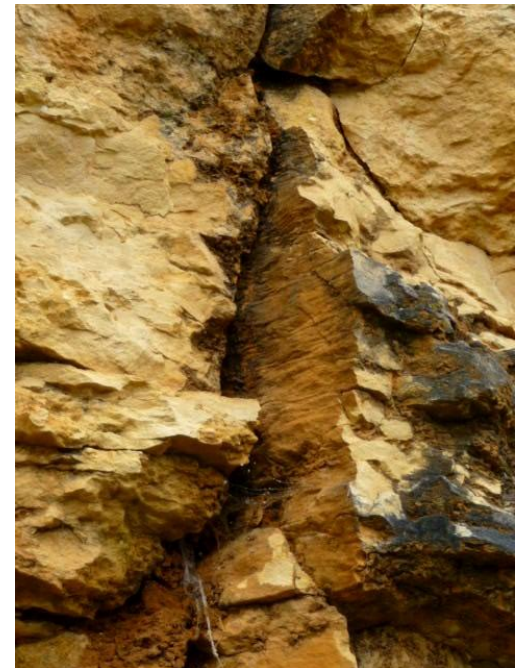
Figure 4 : Diaclase élargie par la circulation de l'eau dans les calcaires gréseux du Turonien, à Couvert
