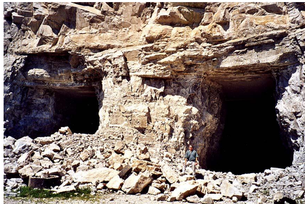
Figure 2 : Entrée des anciennes carrières souterraines de La Passée à Saint-Cyprien, ayant exploité les marno-calcaires du Kimméridgien supérieur pour la fabrication de ciment naturel
