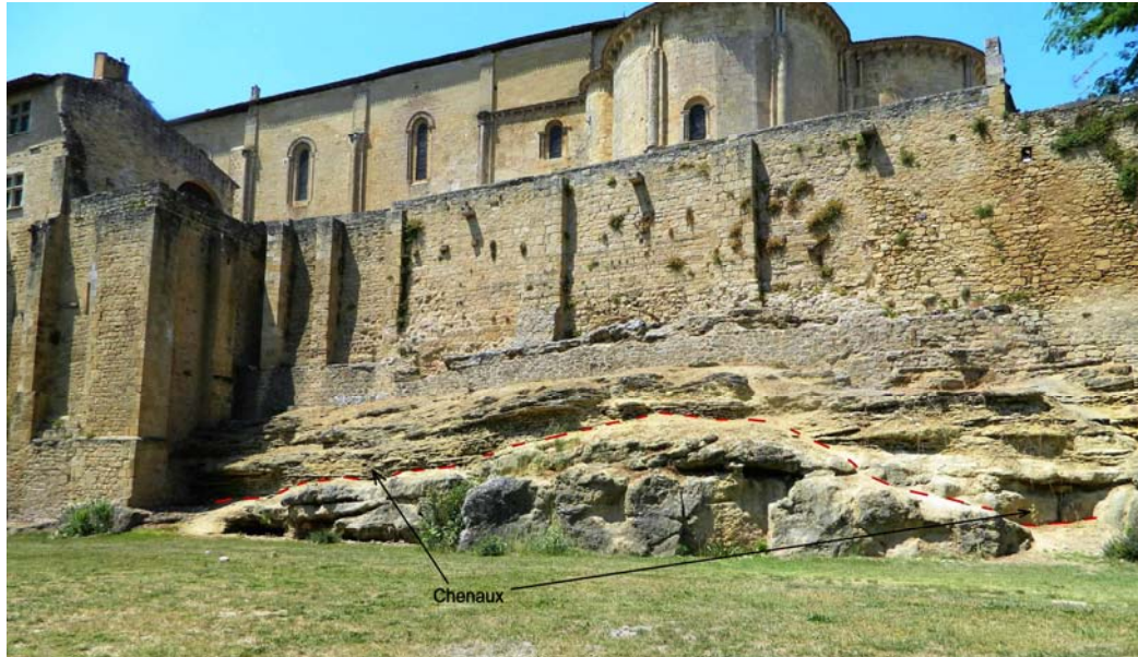
1- Remparts de S t -Macaire bâtis sur le calcaire à Astéries : on observe à l'affleurement les deux niveaux du calcaire à Astéries. La surface d'érosion entre les niveaux inférieur et supérieur est indiquée par des pointillés rouges.
