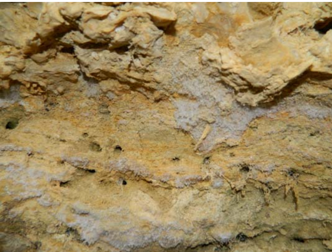
2 - Suintements de syngénite à la base des bancs d'huîtres (zoom de l'encadré noir de la photo ci-dessus) : La syngénite est un minéral (un sulfate hydraté de calcium et potassium) qui apparait en surface par suite du lessivage des minéraux contenus dans la roche (infiltration de l'eau, dissolution et re-précipitation).
