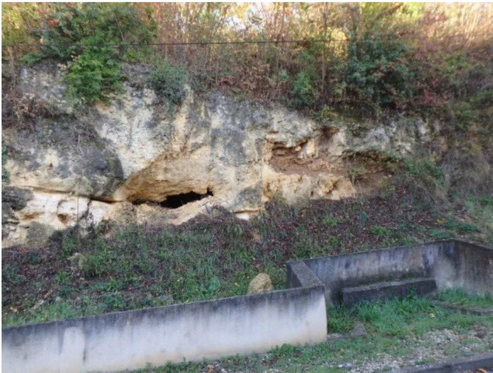
Figure 6 : Cavité karstique, visible dans le calcaire à Astéries (© Bourbon P., 2017)
