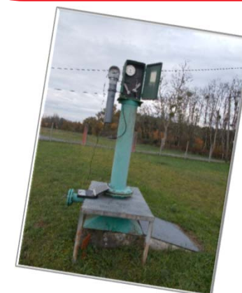
↑ Piézomètre situé sur la commune de Budos (08518X0002)
