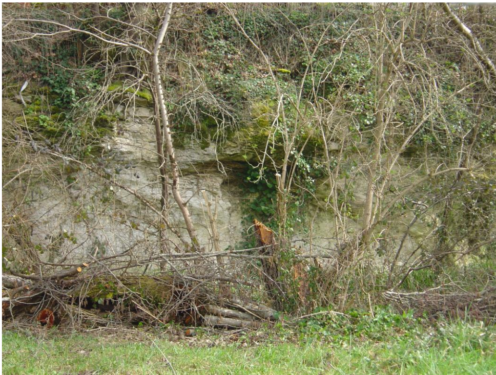
Figure 1 : Petite falaise de calcaire blanc, en bordure orientale du ruisseau de Baillard (Platel JP., 2014)
