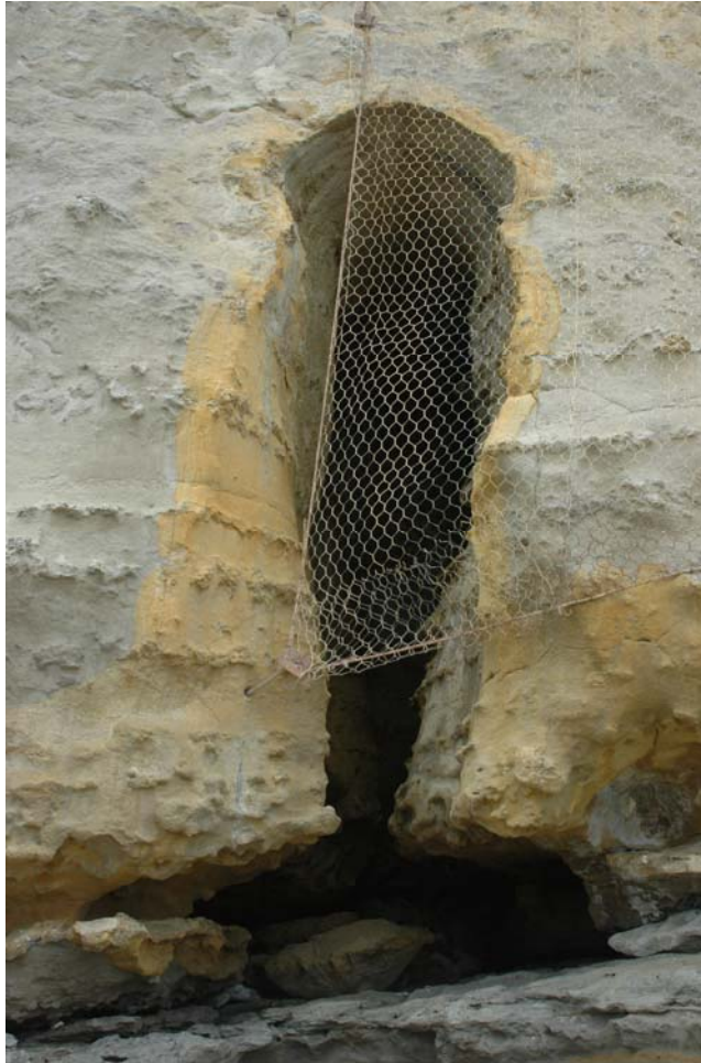
Figure 4 : Grotte ouverte dans les calcaires gréseux, sur la plage de Miramar à Biarritz
