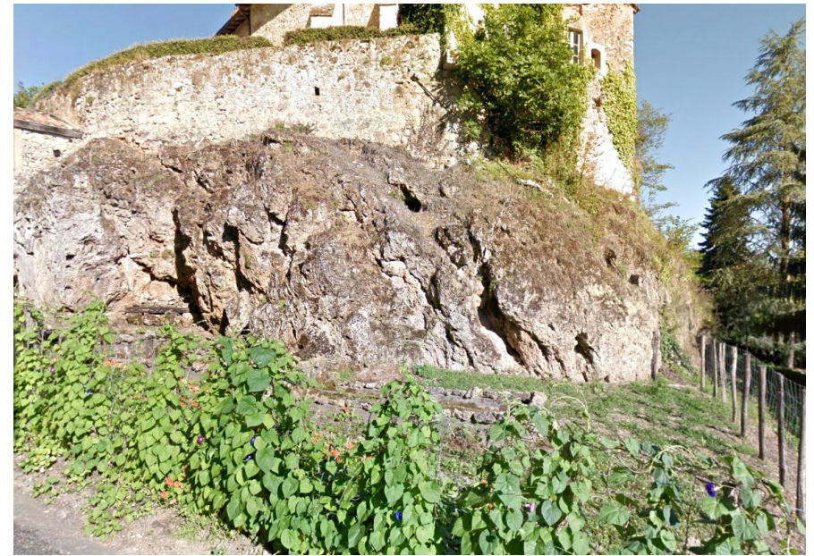
Figure 3 : Tuf sur lequel est bâtie l'église de Sourzac
