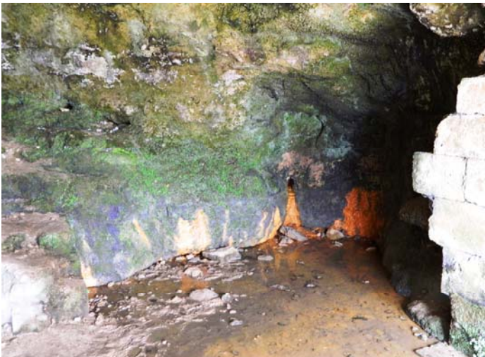
Intérieur de « la grotte de Charles VII » - source de Rions : En rive droite de la Garonne, les calcaires à Astéries affleurent sous forme de falaises plus ou moins développées. A Rions, une citadelle est bâtie sur ces calcaires et une source suinte à sa base (source de « la grotte de Charles VII »).
